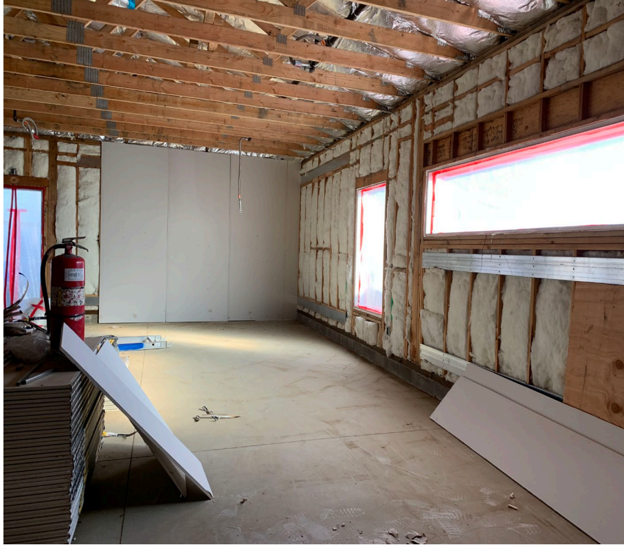
Kinder Room 108 Drywall
