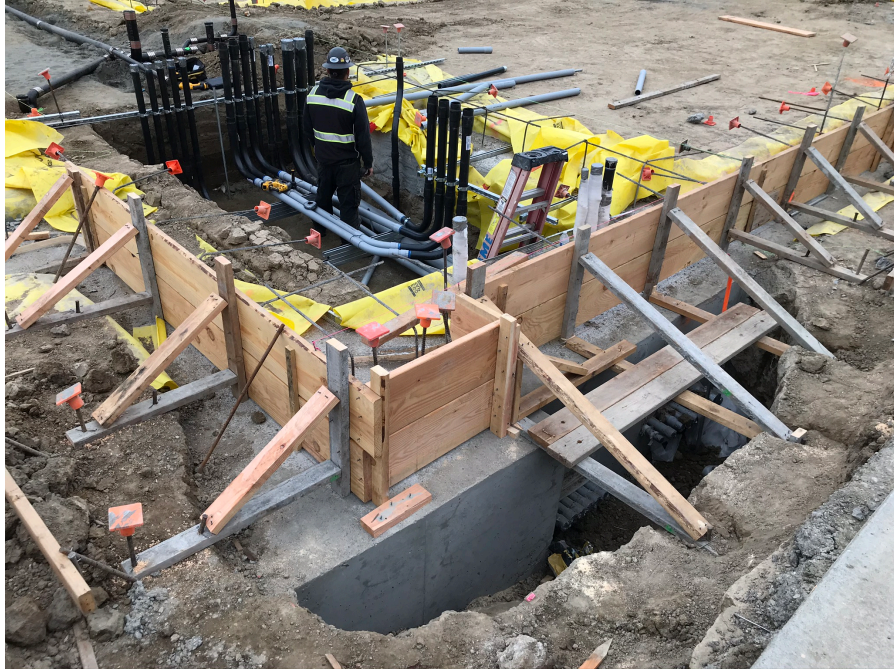
Gym Electrical Room Conduits
