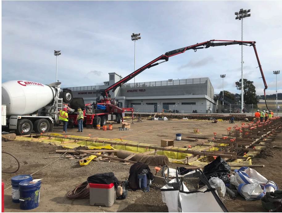
Gym Footing Concrete Pour
